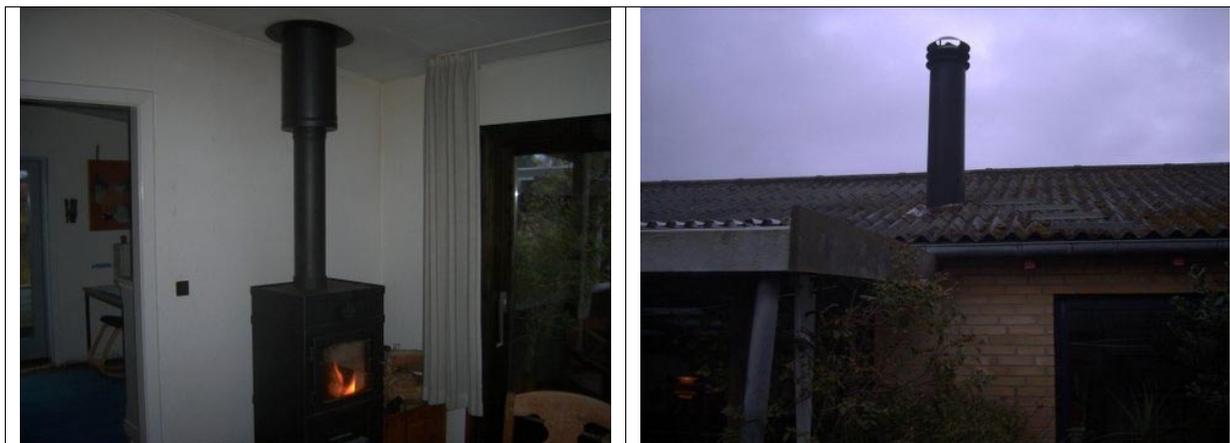
**Skorsten:** Lige op stålskorsten  $\varnothing$  15. Isoleret 2 m og uisoleret 80 cm
