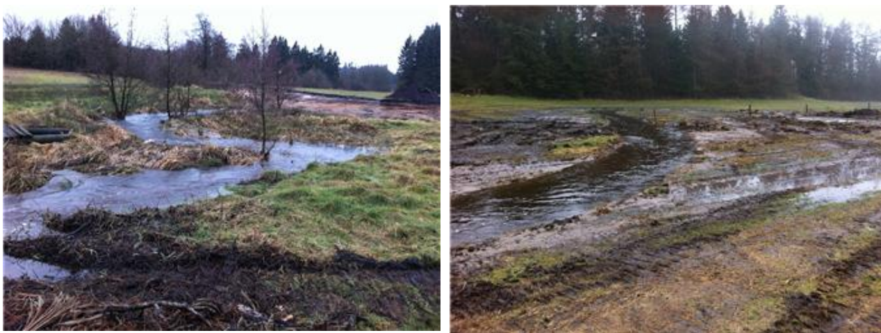
Figur 6.2. Venstre: Odderbæk efter tilbageførsel til det oprindelige løb. Højre: Oversvømmelse på de tilstødende marker efter genslyngning. Fra: http://www.vejle.dk/page48744.aspx . Foto: Matthew Cochran, januar 2011.
