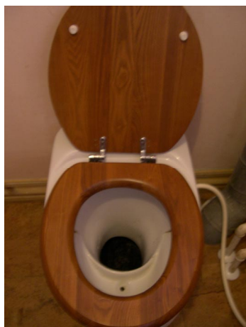
Figur 2.1 Eksempel på et komposttoilet med urinseparerende kammer. Fotograf: Maj-Britt Quitzau.
