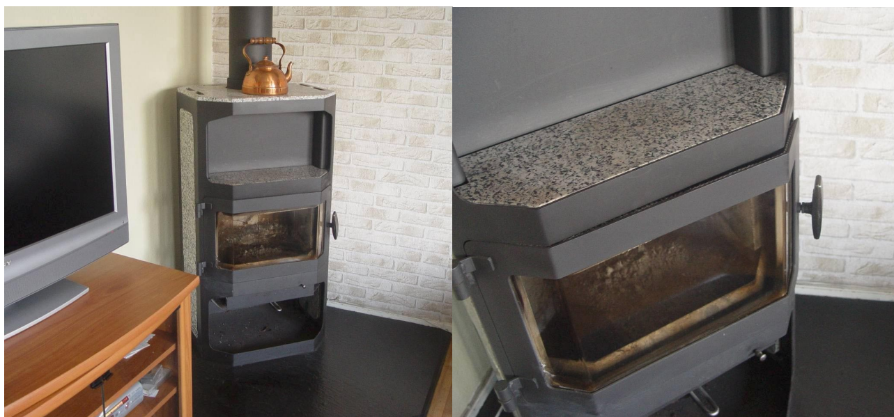
Figur 8.4. Ovnen i huset med brændeovn. Til højre er vist, hvordan ovndøren typisk stod på klem under optænding.
