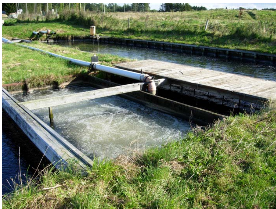
Figur 3.15 Dobbeldam på Silstrup dambrug anvendt til formalinforsøg. To parallelle damme er forbundet med en airlift i den ene ende og en kanal i den anden, der sikrer en stor grad af recirkulering. Under forsøget blev der lukket for ind- og udløb, og opblandingen af salt og formalin blev sikret med en padlebelufter.
