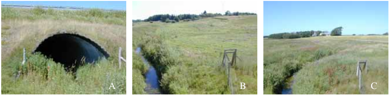
Figur B51. A: Stade-Mellerup Bæk, vådpassagens østlige åbning. B: Det omgivende landskab mod øst med elektrisk hegn langs vandløbet. C: Det omgivende landskab mod vest.
