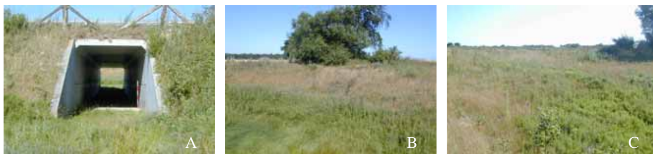
Figur B4. A: Vestbjerg, tørpassagens østlige åbning. B: Gammelt dige og dyreveksler mod nordvest. C: Mod nordøst en rest af et gammelt dige med jernbanelinjen Nørresundby-Brønderslev i baggrunden.
