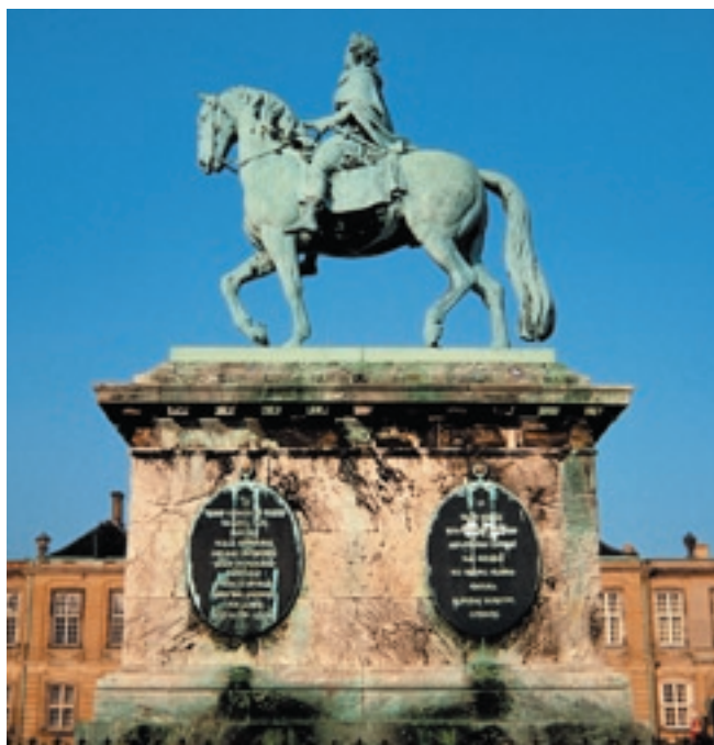
Figur 3-9 Saly's ryttermonument for Frederik V på Amalienborg Slotsplads i København. Det blev opstillet i 1770, og er her fotograferet i 1982. Det er helt dækket af korrosionsprodukter.
