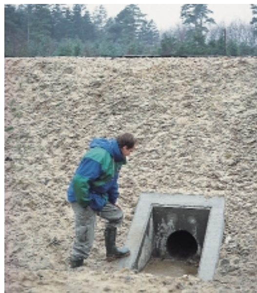
Rørunderføring under motorvej E 45
